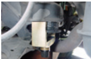
角目世代のメルセデスでは劣化が目立ってきているサブフレームマウント。SSTがない場合はサス回りをバラす必要がある。
