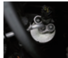
エアコンのガス漏れなども確認。費用がかかる部分なので重視しているようだ。
