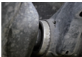
見た目では問題なさそうだったロアアームブッシュに小さな亀裂を発見したが、まだ使用できるという判断だった。
