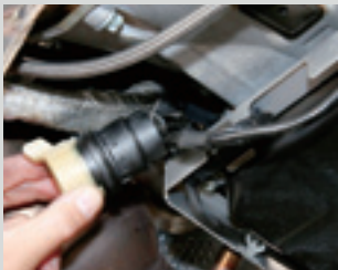
電子制御式ATに多いカブラーやオイルパンからのオイル漏れ。漏れがひどくなる前に対処しておくことが、トラブル回避のポイント。
