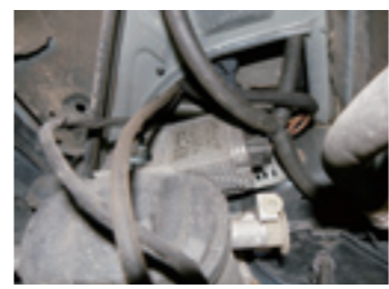
フロントバンパーの裏にある電動ファンのコントロールユニット。ファンの回転を4スピードにコントロールする最新型のレジスターだ。こんな部分もDIYで交換が可能か。
